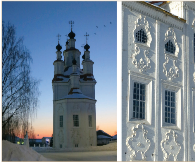
Илл. 3. Храм Входа Господня в Иерусалим. Город Тотма Вологодской области Высотность основного объема и картушный декор стен. 2021 г.
