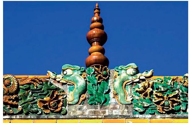
Илл. 2. Пример островерхой части крыши баодин в виде тыквы-горлянки
