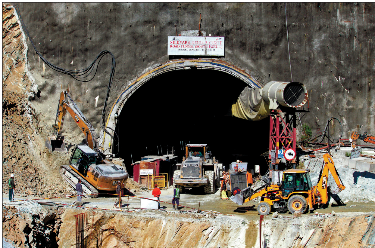
Илл. 9. Спасательные работы в обвалившемся тоннеле Силкьяри в Уттаркаши. 18 ноября 2023 г.
